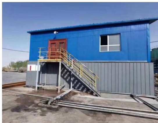
生产废水处理站
