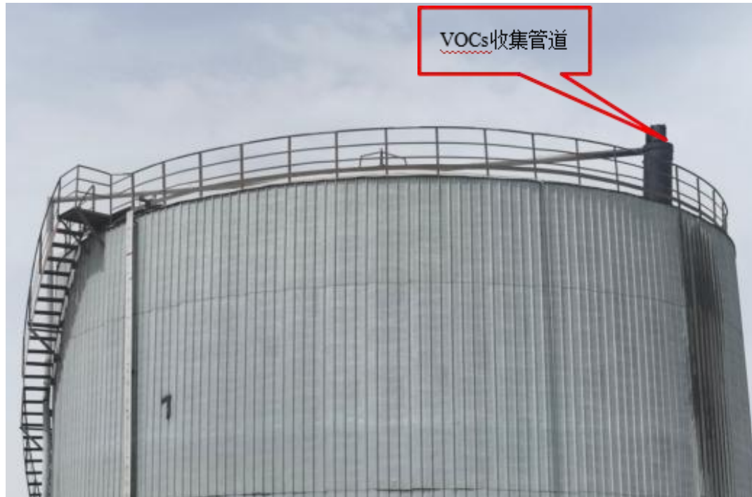
图 4.4-1 葱油储罐 VOCs 收集管道示意图
